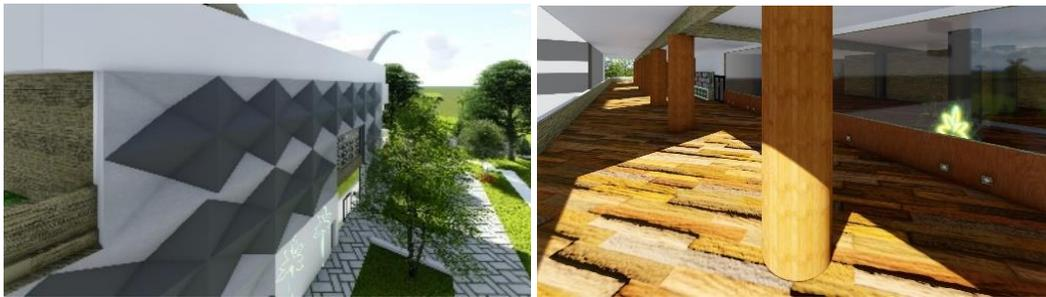
*Gambar 9 Cladding metal dan cladding kayu*
