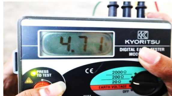
Gambar 3. Pengukuran pentanahan peralatan
