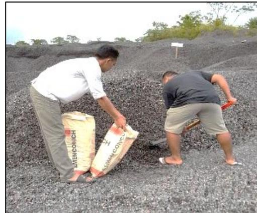
Gambar 6. Pengadaan Agregat Kasar Pembuatan Benda Uji Silinder
