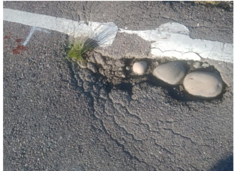
Gambar 5. Kerusakan Ambblas Dan Retak Pada Perkerasan Lentur Jalan
