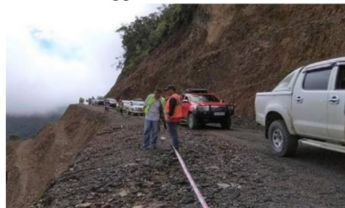
Gambar 3. Kerusakan jalan tipe retak pinggir
