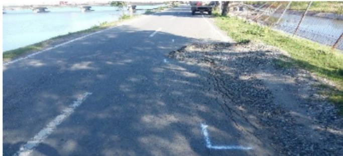
Gambar 4. Kerusakan jalan tipe retak memanjang
