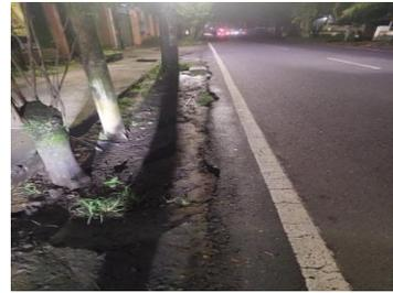
Gambar 4.5 Edge Cracking
